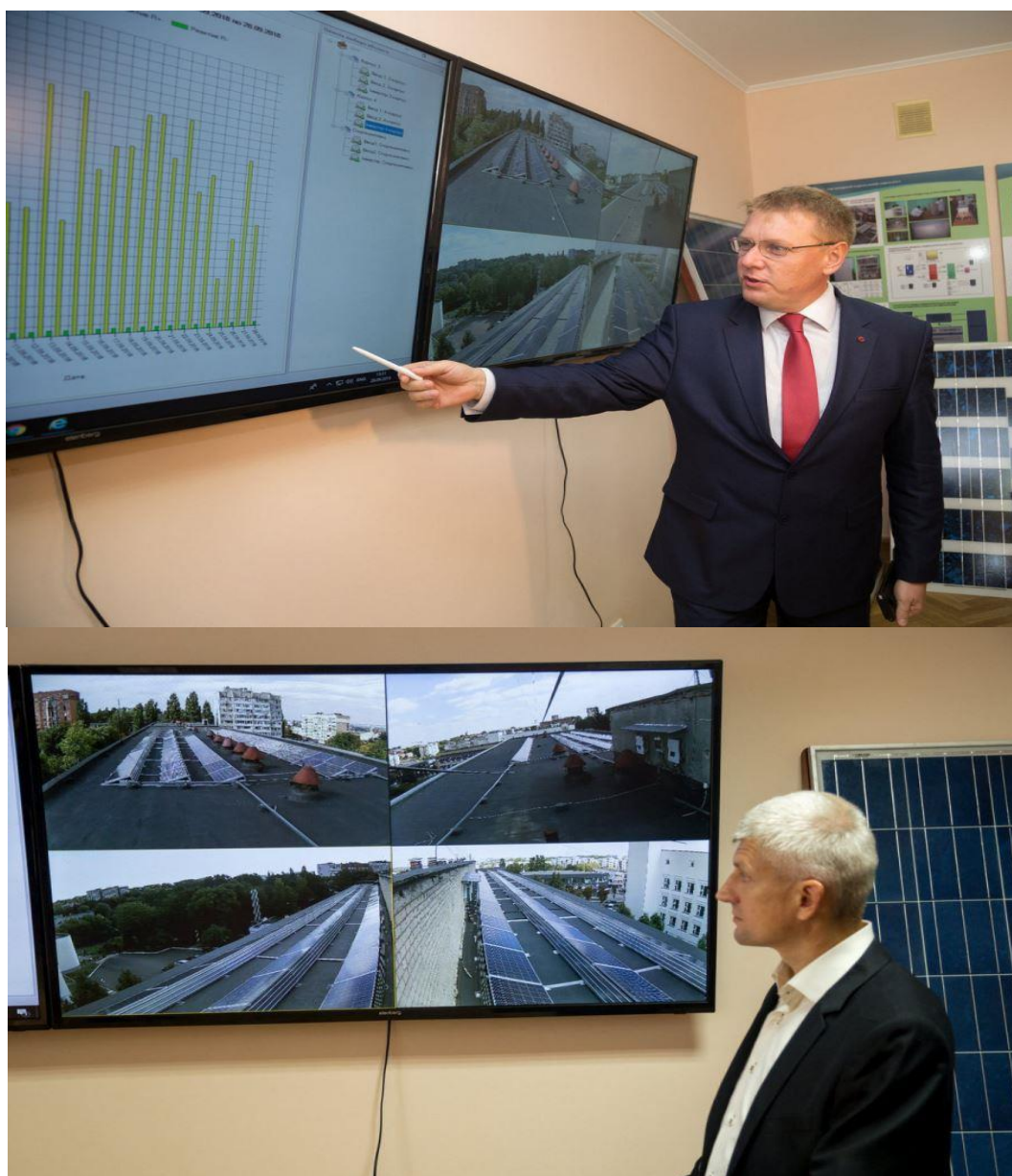
Рисунок 7 – Диспетчерський пункт дахової сонячної електростанції
